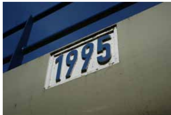
fietstunneltje - Sumpelpad / N343
