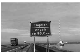
Locatie: Houtribdijk, Enkhuizen-Lelystad Opdrachtgever: Gemeente Apeldoorn Huidige staat: uit de lucht genomen op 31 december 1999, om 24.00 uur Zie ook: www.skor.nl
