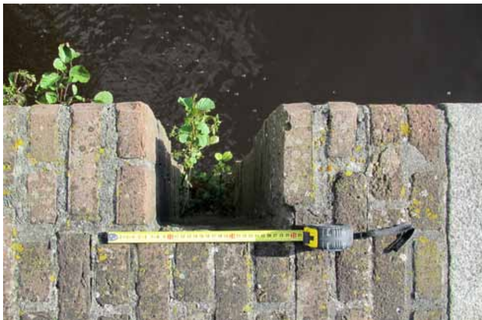
Waterkering, uitsparing om met planken tijdelijk een damwand op te trekken
