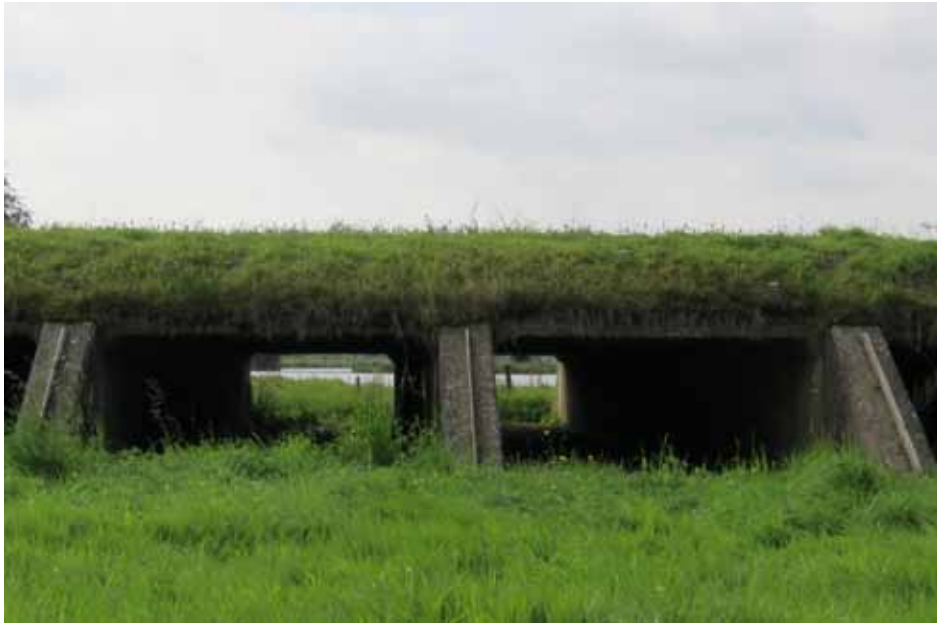
Hardenberg De Brink, aanbrug
