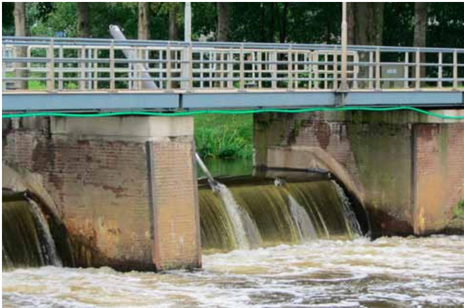
Materiaalgebruik, staal, metselwerk en natuursteen
