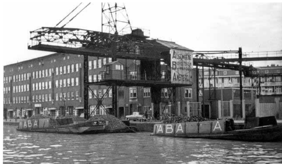
Waar nu de Admiralengracht in de Kostverlorenvaart uitkomt was in de eerste helft van deze eeuw de elektrische los- en kolentransportinrichting van de Algemene Brandstoffenhandel Amsterdam (A.B.A.) gevestigd. Kolen werden hier per boot aangevoerd en met een 'happer' uit het schip gehaald, over de weg getransporteerd, en gestort op een opslagplaats die, d.m.v. verticale betonnen platen, verdeeld was (m.a.w., de kolen werden gesorteerd). Op deze plaats bevindt zich nu het stadsdeelkantoor van 'De Baarsjes'. Om te voorkomen dat kolen, die eventueel uit de happer vielen, de mensen en het verkeer op de weg overlast aan deden, was er een houten vloer onder het traject van de happer geconstrueerd. Nadat er in Nederland grote hoeveelheden aardgas gevonden waren, verdwenen de kolenkachels en het bestaansrecht van de A.B.A.
