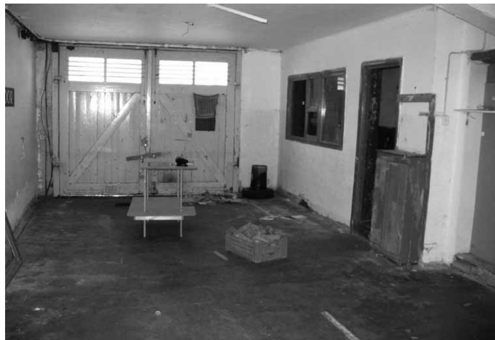
Object: BEDRIJFSRUIMTE ADMIRALENGRACHT 52 HS - DE BAARSJES Bedrijfsruimte gelegen op de begane grond zonder tuin. De tuin wordt gebruikt door de bewoners van 1e verdieping. Tot voor kort is deze ruimte in gebruik geweest als werkplaats en opslag. Een onderstuk van circa 60 M2 met grote inrijdeuren. Vraagprijs: € 100.000,- K.K.
