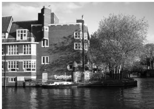
Voormalige Edelsmedenschool, gezien vanaf de Baarsjesweg bij het Stadsdeelkantoor, okt.2004
